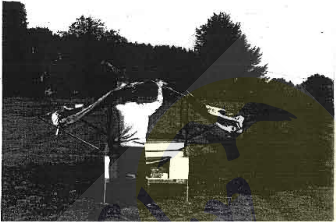
Photo 5 : Connectez les deux portics au centre (tubes avec cliquets) Bevestig de twee losse buizen aan elkaar om het middenframe te maken. Dit zowel aan de voor-als achterzijde (buizen met klikveren) Connect the 2 hinged arms to form the central roof support
